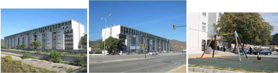
Fotos edificio pre-rehabilitación energética (2011-2012)
