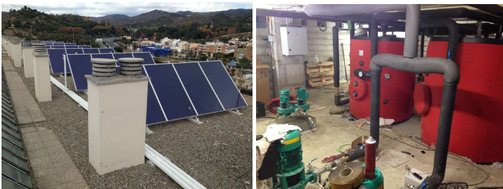
Fotografías edificio durante intervención en cubierta y sótano (2011-2014)
