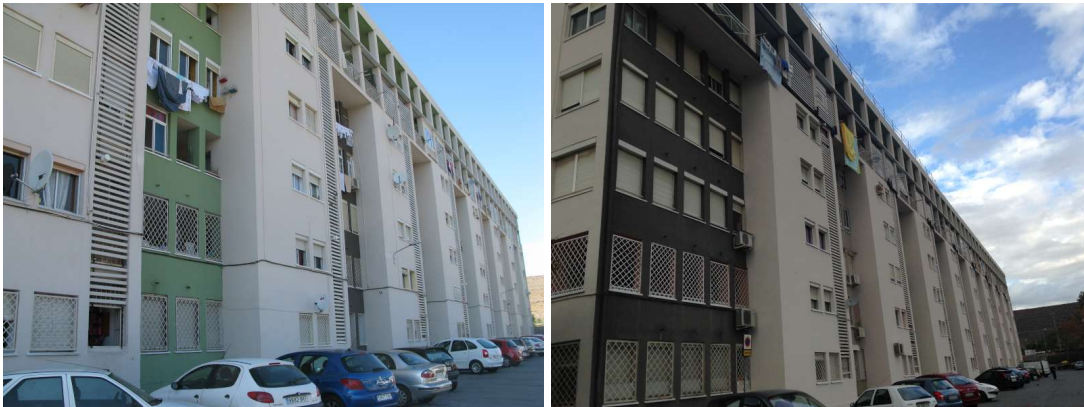
Fotografías edificio pre y post intervención en fachada (2011-2014)
