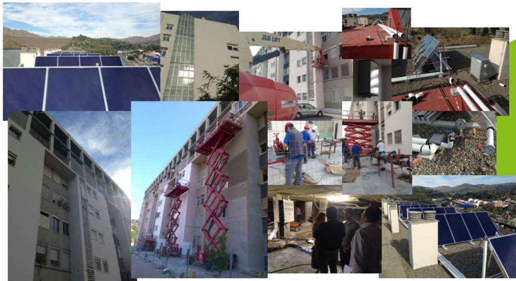
Fotografías edificio durante la rehabilitación energética (2011-2014)
