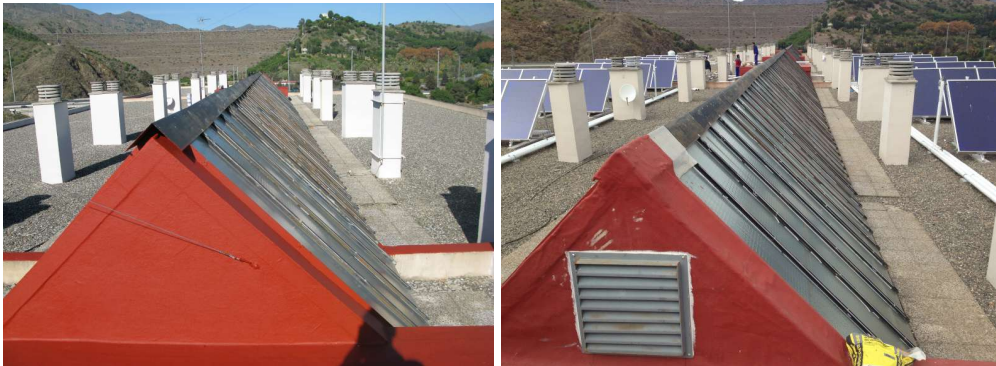
Fotografías edificio pre y post intervención en cubierta (2011-2014)
