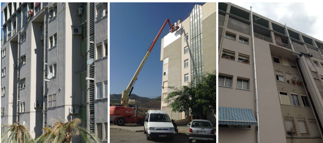
Fotografías edificio pre y post intervención en fachada (2011-2014)
